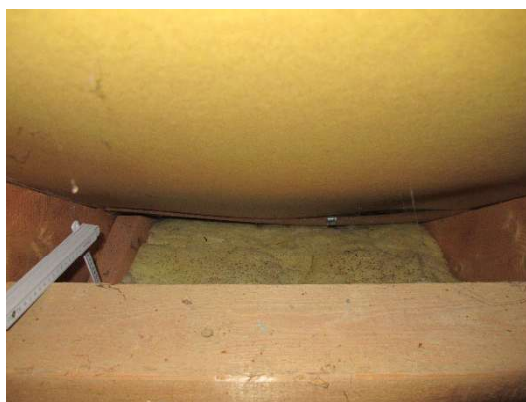
Illustration 5 Isolation thermique du sol des combles
