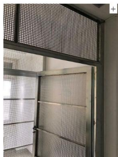
Gitterwände und Gittertüre 4 Stk. Canton: ZH Démonatg avant : semaine/année 27 / 2023
