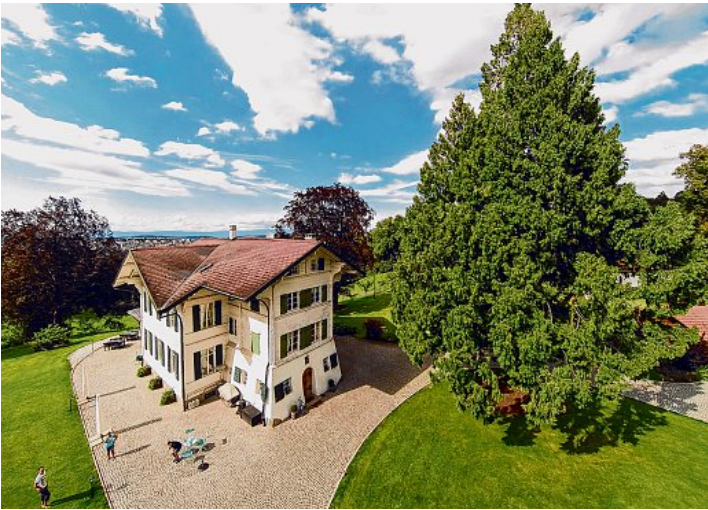
Das 150 Jahre alte Haus in der Schürri in Pierrafortscha soll energietechnisch auf Vordermann gebracht werden.
