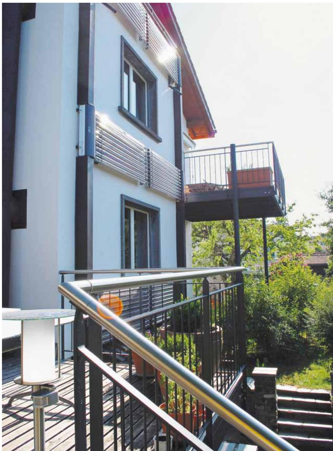
Bei diesem Haus wurden die alten Balkone, die Kältebrücken bildeten, ganz von der Fassade abgetrennt und durch neue, grössere ersetzt.
